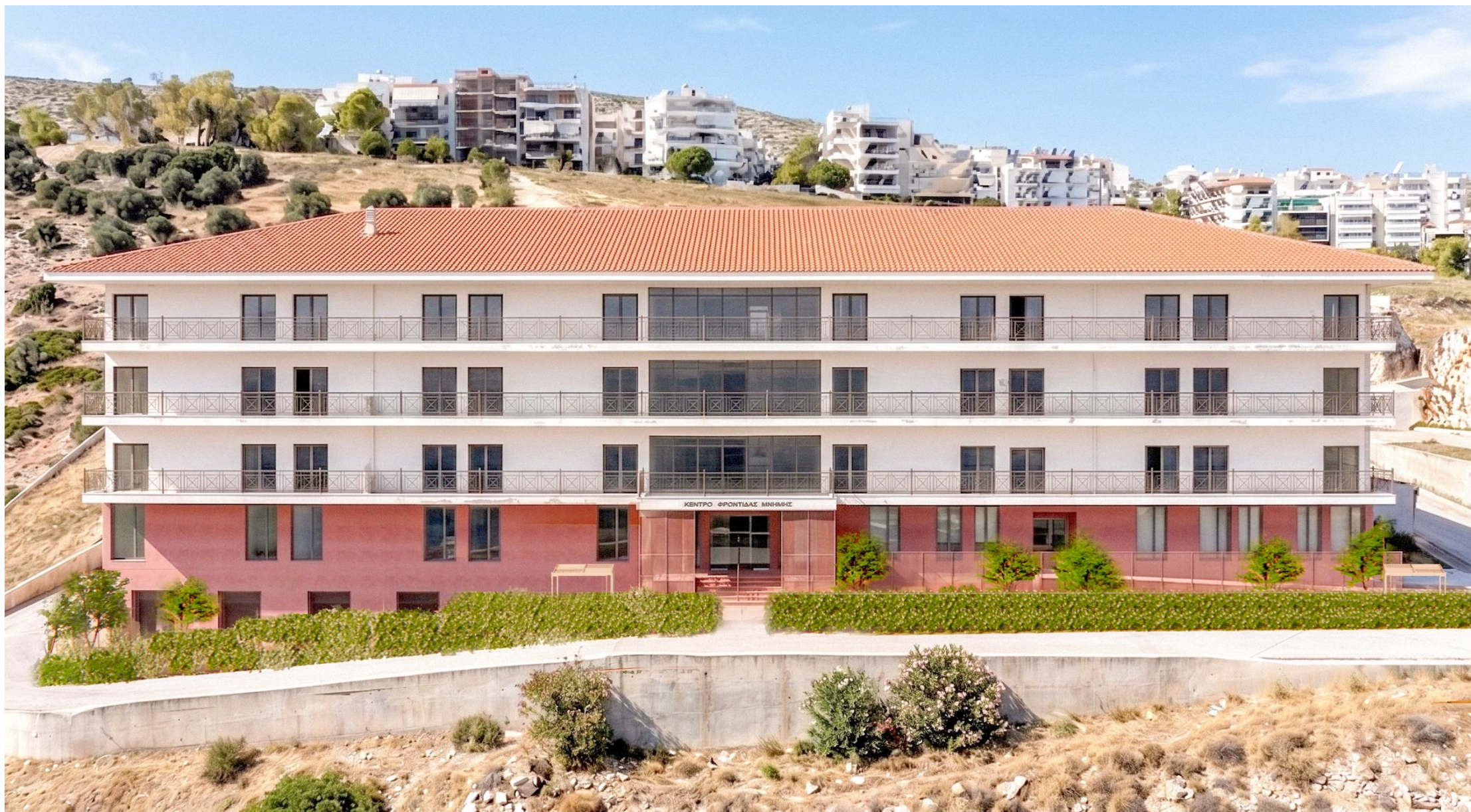
ΤΟ ΙΣΟΓΕΙΟ ΤΟΥ ΚΤΙΡΙΟΥ ΜΕΤΑΤΡΕΠΕΤΑΙ ΣΕ ΠΡΟΤΥΠΟ ΚΕΝΤΡΟ ΑΝΟΙΑΣ
